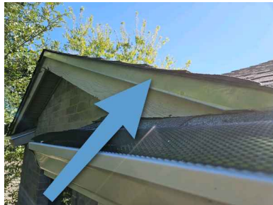
Drip edge flashing
